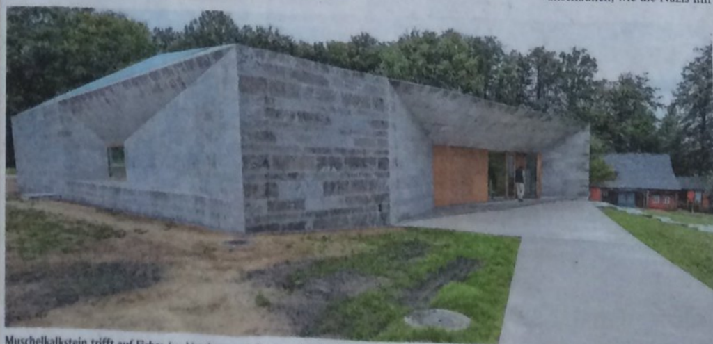
Muschelkalkstein trifft auf Fichte: Im Vordergrund das neue Böckstiegel-Museum, im Hintergrund das Eltern- und heutige rote Künstlerhaus.
